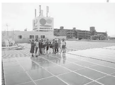
ながお店の屋根には「リアルに協同発電しよ・ながお」のソーラーパネルが設置されています(量約100枚分)
