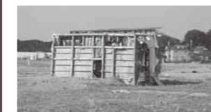
濁流に流された家屋が横向きに倒れたままになっていました
