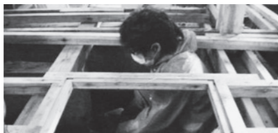
がれき撤去・家屋整理の活動にて。津波の影響で家の床下部分に入った泥を撤去しています
