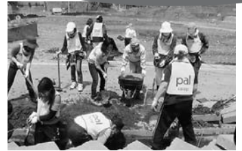
側溝のドロ出し作業
