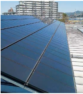
支所の屋根に設置している太陽光パネル
